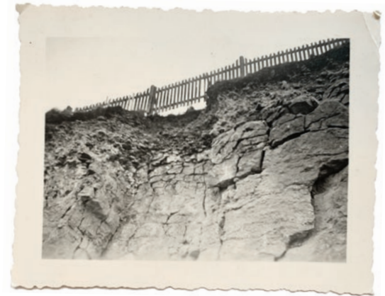
Blick aus dem nördlichen Steinbruch zur Straße „Röse“ hin, 1920er Jahre
