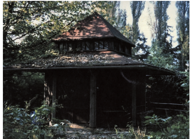
Das Teehaus in den 1980er Jahren: zugewachsen, fensterlos und stark beschädigt.
